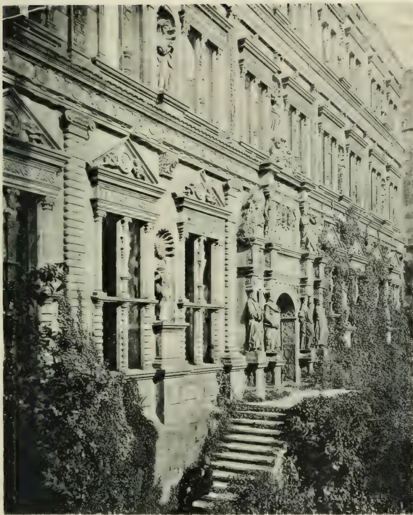
ABB. 4. PORTAL DES OTTO HEINRICHS-BAUES.
